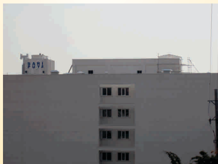
پروژه بام دربند - تهران
