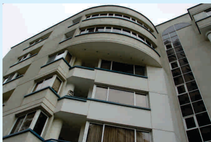
پروژه چهار باغ الهمیه
