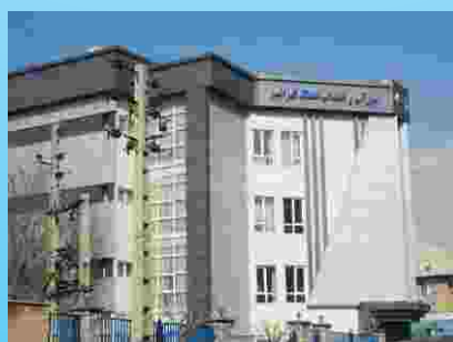
پروژه امور آب و فاضلاب تهرانسر
