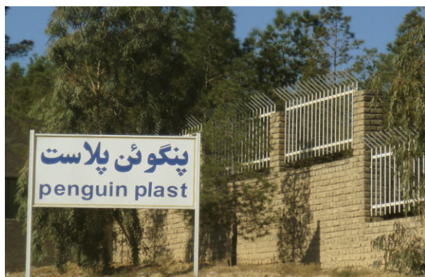
پروژه پنگوئن پلاست - قم ۲ دستگاه چیلر به ظرفیت ۸۰۰ تن تبرید
